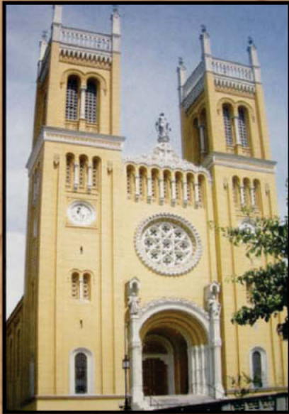
A felújított Főti templom
