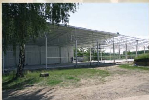
Épül a raktárcsarnok 2004
