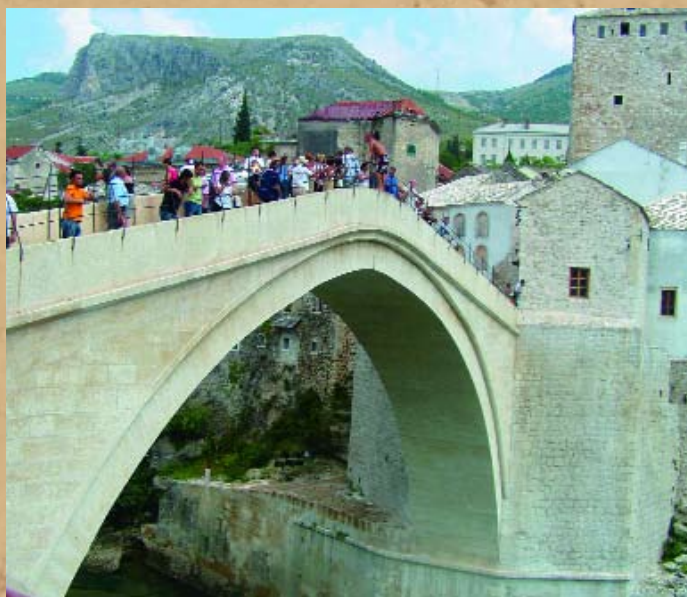
Mostar - az újjáépített híd
