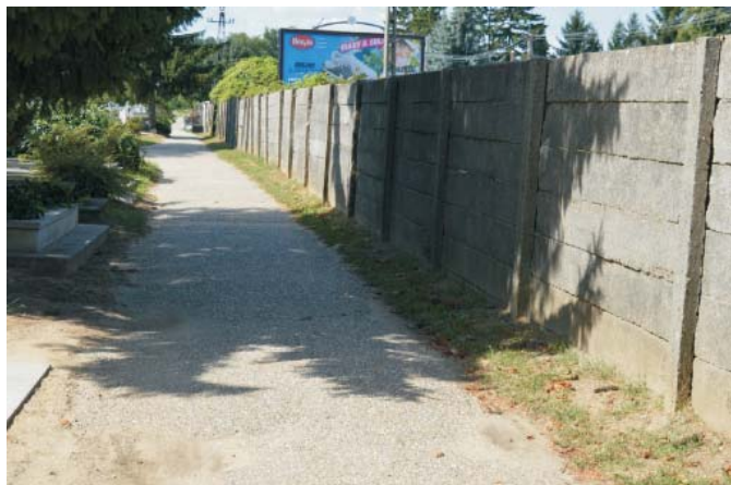
A kerítés cseréje a temető Jutai út felőli oldalán.
